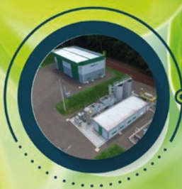
ESTAÇÃO DE TRATAMENTOS DE EFLUENTES
