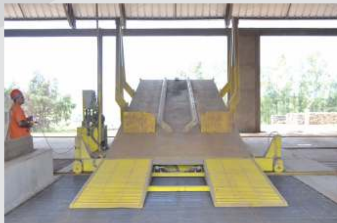
Inclui trilhos guia centrais, travas de rodas traseiras e rampa metálica grelhada que permite o acesso à Plataforma.
