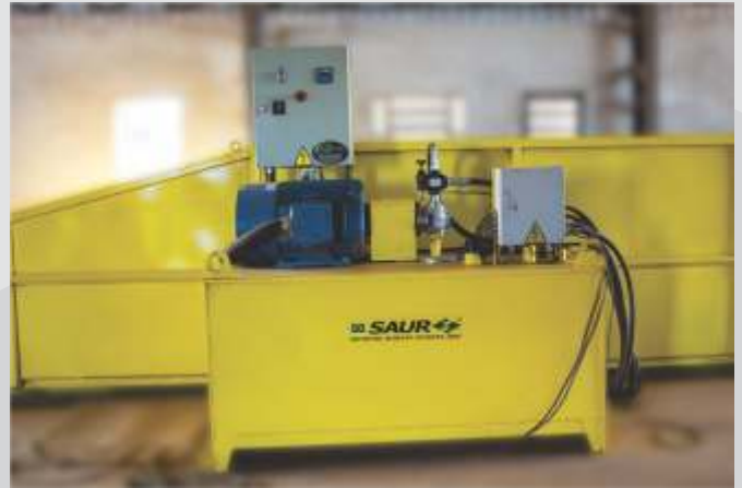
Unidade Hidráulica da Plataforma de Descarga.
