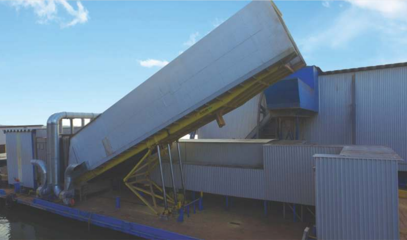
Plataforma de Descarga sobre Barcaça
