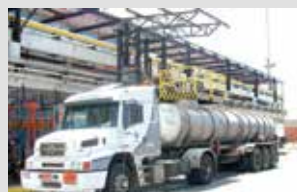
Torre Elevadora para acessar o bocal de inspeção de caminhões tanque.
