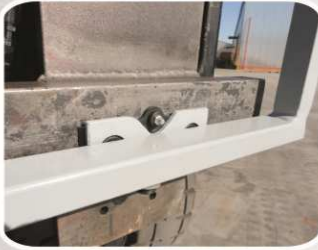
Presilhas inferiores com pastilhas deslizantes.
